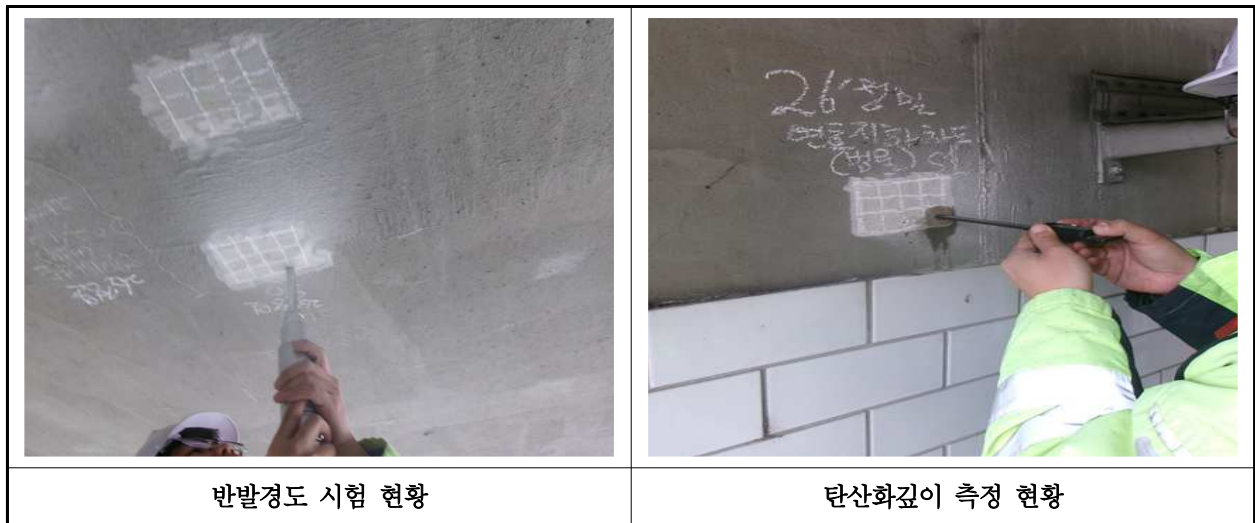
【사진 1.4.1】 콘크리트 내구성조사 현황
