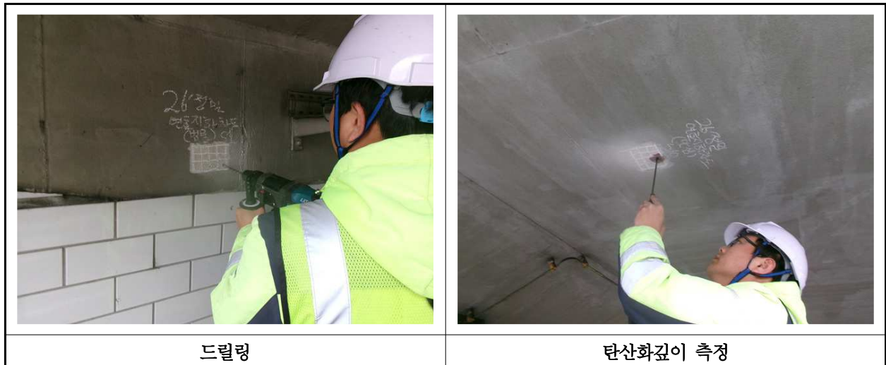
【사진 1.4.3】 탄산화 깊이 측정 현장사진
