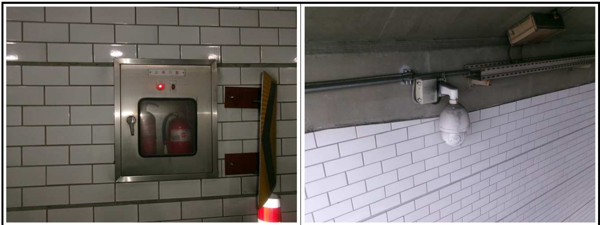
【사진 1.3.12】 부속시설 전경
