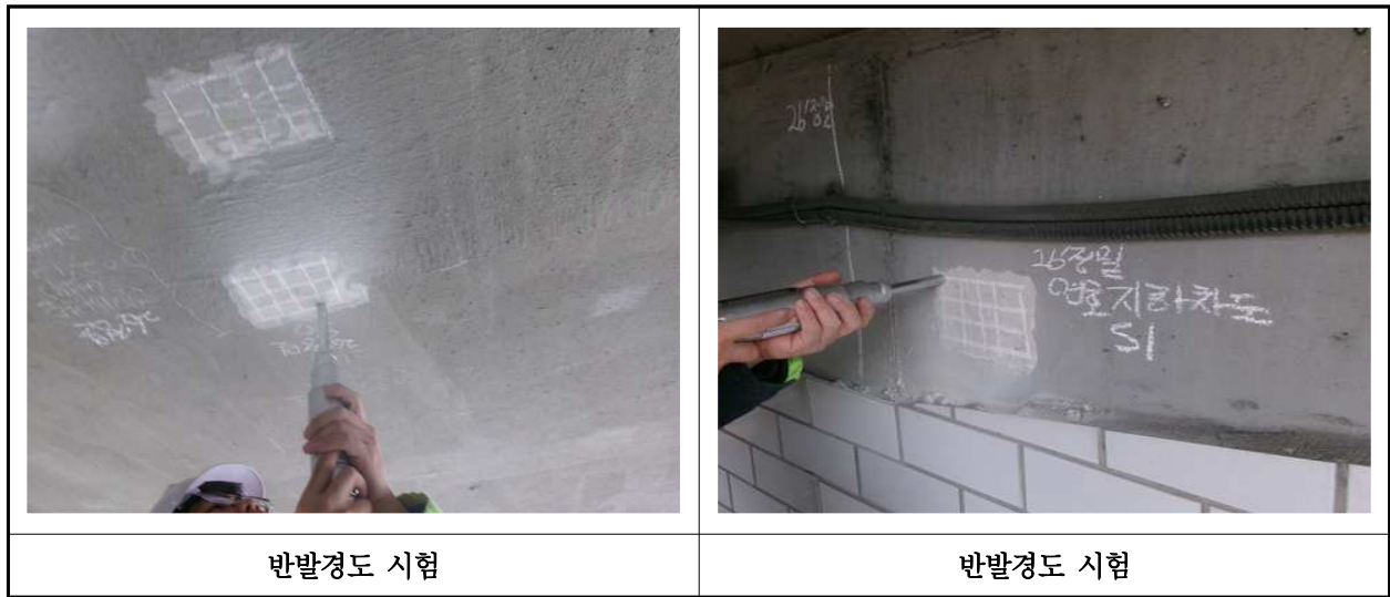
【사진 1.4.2】 반발경도시험 현장사진
