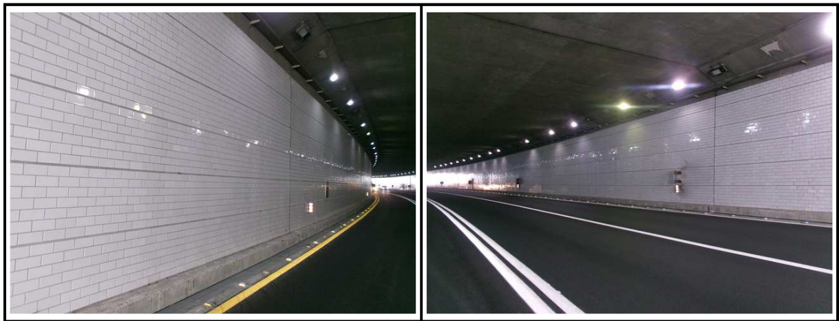
【사진 1.3.6】 BOX구간 벽체 전경
