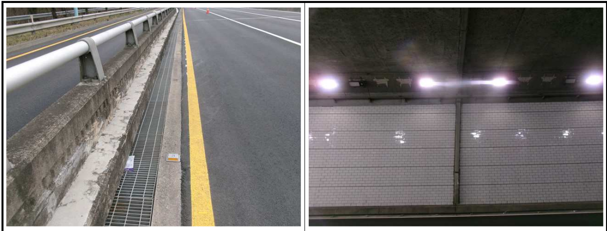
【사진 1.3.10】 배수시설 전경
